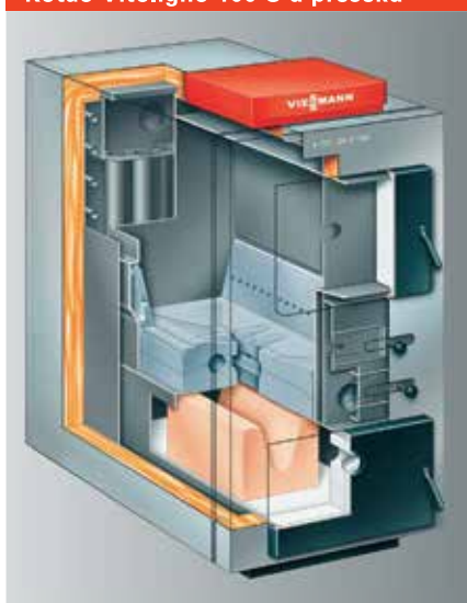
Kotao Vitoligno 100-S u preseku
